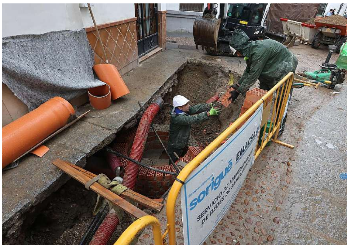
Imagen de unas obras de Emacsa valerio merino
