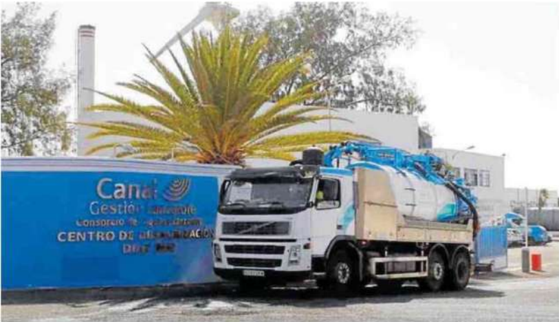
Instalaciones junto a Las Caletas, donde se albergan varias desaladoras. c7
